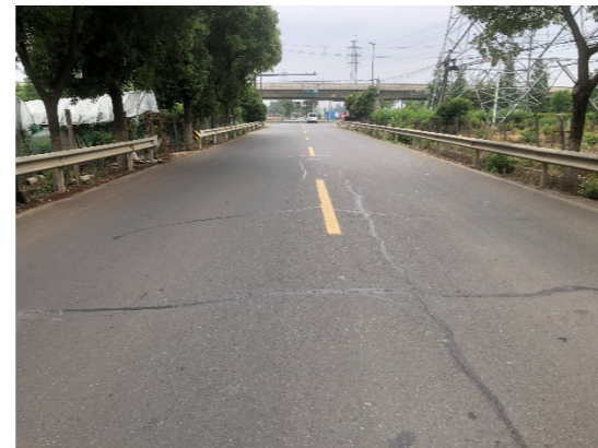
图 4-24 横向裂缝
