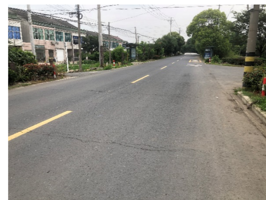
图 4-26 横向裂缝
