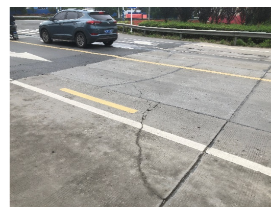
图 4-10 板角破损
