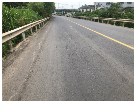
图 4-25 纵向裂缝
