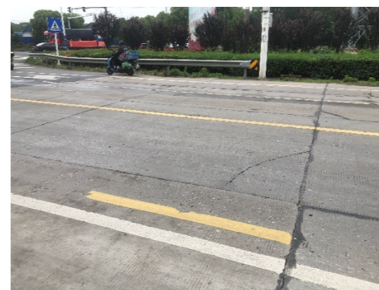
图 4-9 板角破损
