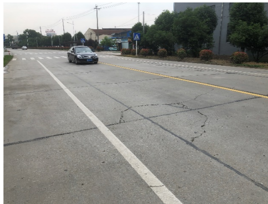
图 4-13 板角破损
