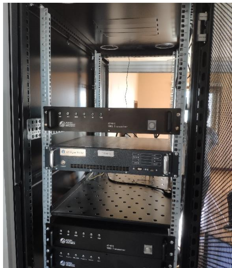
图 4-7 增强型 AIS 基站室内安装示意图
