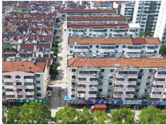
屋面存在破损漏水现象；太阳能摆放和管线杂乱影响风貌；屋顶防雷设施老旧。
