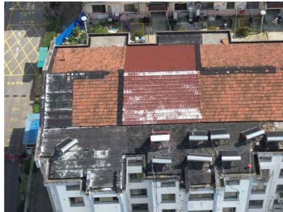
屋面存在破损漏水现象；太阳能摆放和管线杂乱影响风貌；屋顶防雷设施老旧。
