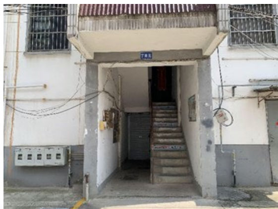
单元门雨棚瓦片存在不同程度破损；缺少单元门灯，部分楼道灯损坏不亮；楼道内部墙皮剥落，部分设施老旧线路杂乱。
