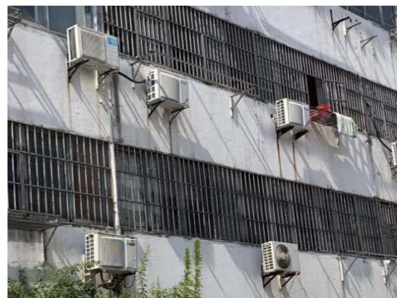
立面设施老旧，空调机架锈蚀；立面管线部分杂乱；厨房排烟口缺少遮挡。
