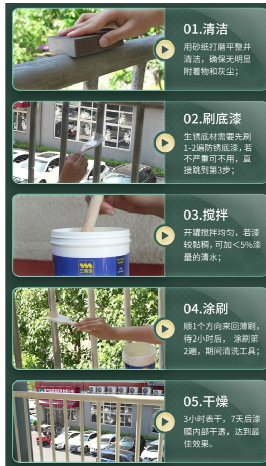
刷涂防锈漆工序示意
