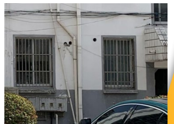
立面设施老旧，空调机架锈蚀；立面管线部分杂乱；厨房排烟口缺少遮挡。
