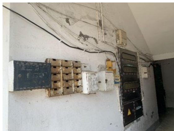
单元门雨棚瓦片存在不同程度破损；缺少单元门灯，部分楼道灯损坏不亮；楼道内部墙皮剥落，部分设施老旧线路杂乱。
