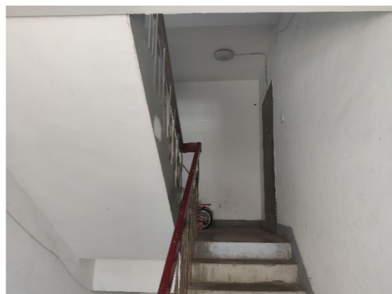
单元门雨棚瓦片存在不同程度破损；缺少单元门灯，部分楼道灯损坏不亮；楼道内部墙皮剥落，部分设施老旧线路杂乱。
