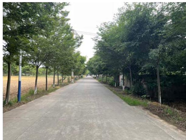
常长线现状排水照片
