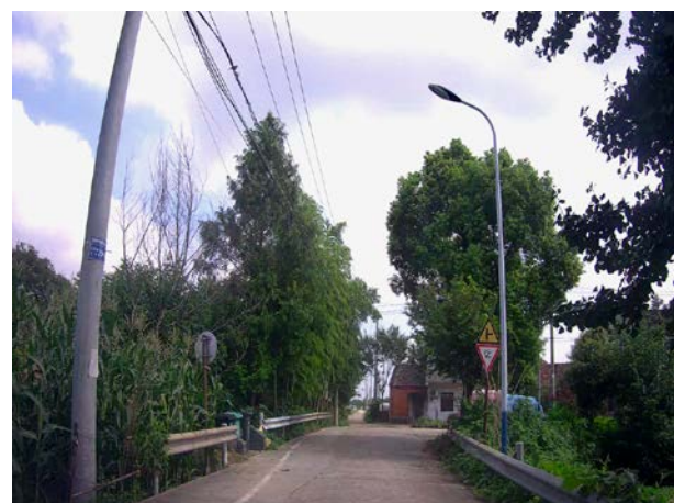
标志牌老化、波形梁护栏缺少端头
