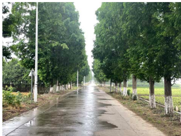
西三线现状排水照片
