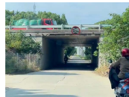
下穿沪武高速照片
