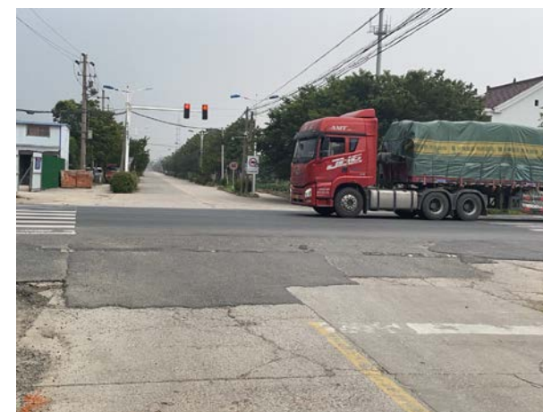
X202 建社线交叉口照片
