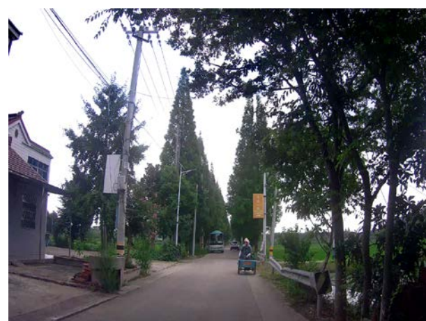
波形梁护栏损坏
