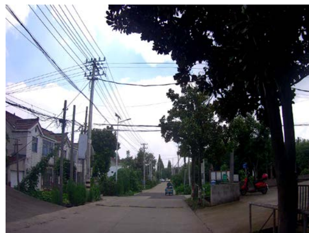
道口标柱老化、缺失
