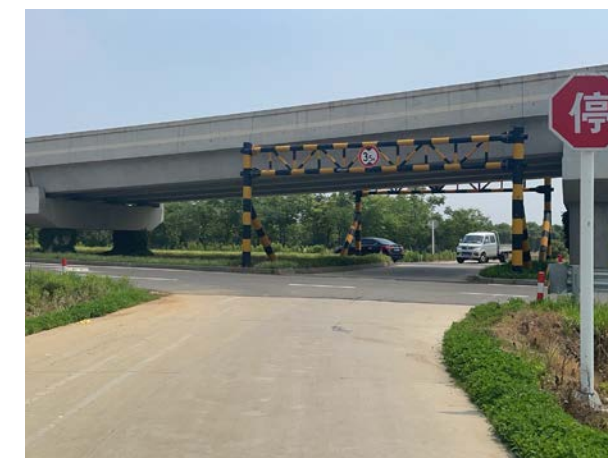
X203 延西线辅道交叉照片
