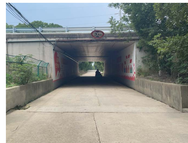
下穿扬溧高速照片
