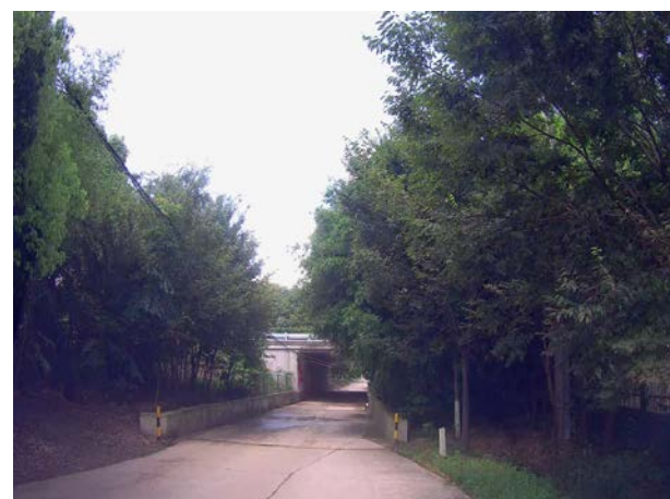
上跨桥桥墩缺少警示
