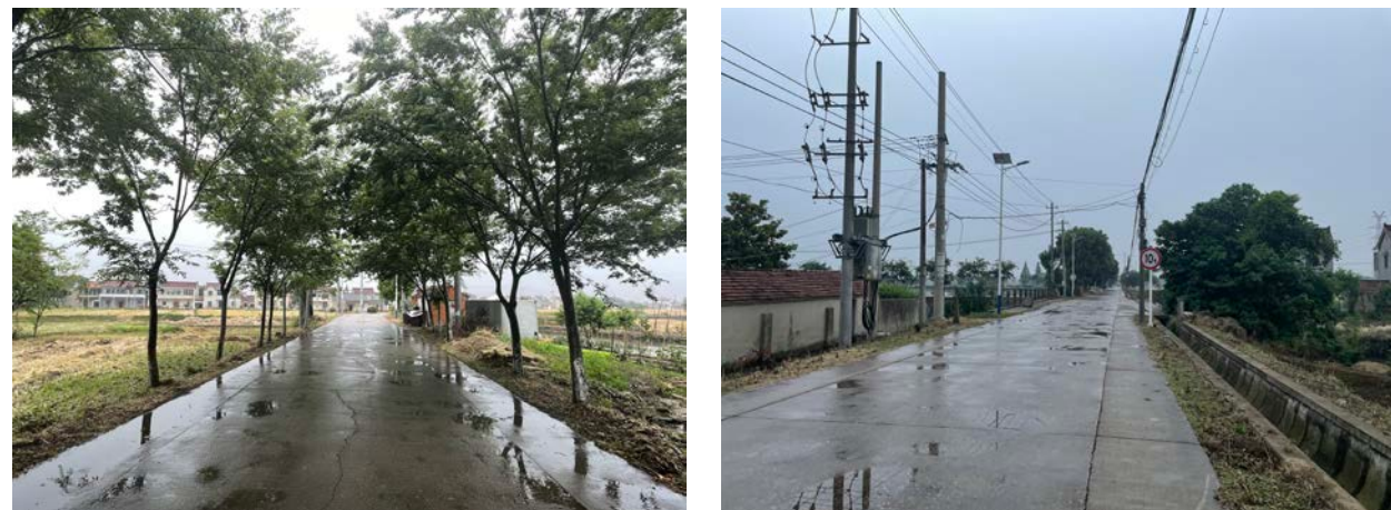
西圩线现状排水照片
