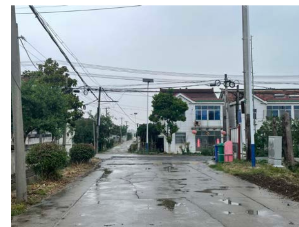
西三线交叉口照片
