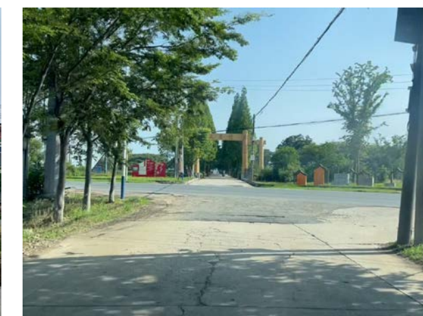
X202 建社线交叉口照片
