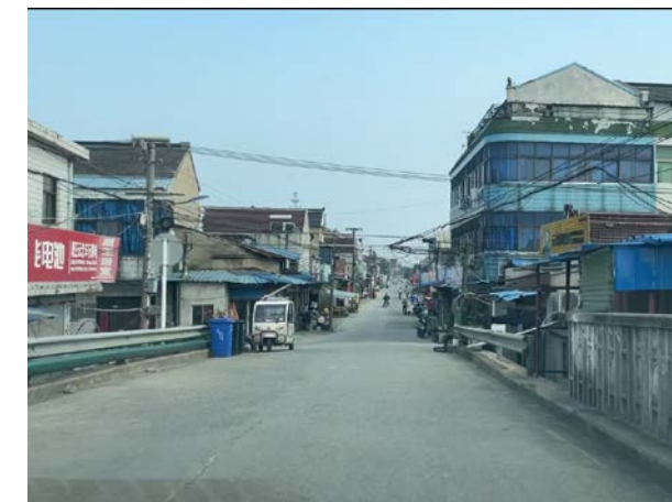
波形梁护栏缺少端头
