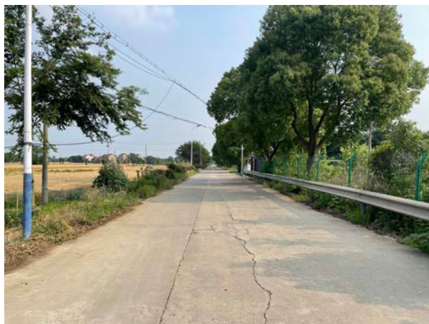
常王线现状排水照片
