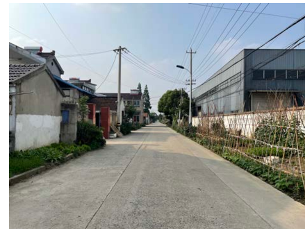
常王线一般路段横断面现状
