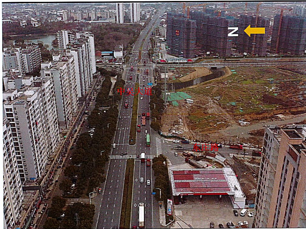
图 4.15 东庄路交叉口航拍图
