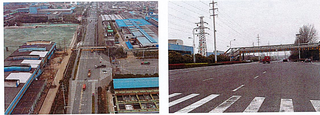
图 4.10 标线磨损严重
