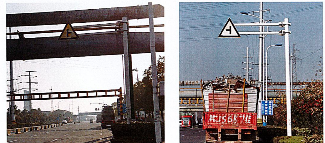
图 4.9 警告标志反光膜老化
