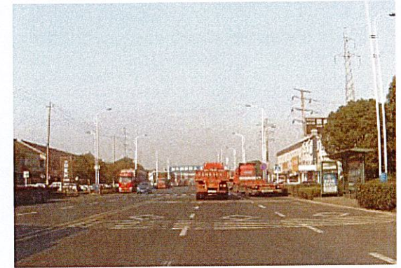
图 4.13 中分带现无隔离设施
