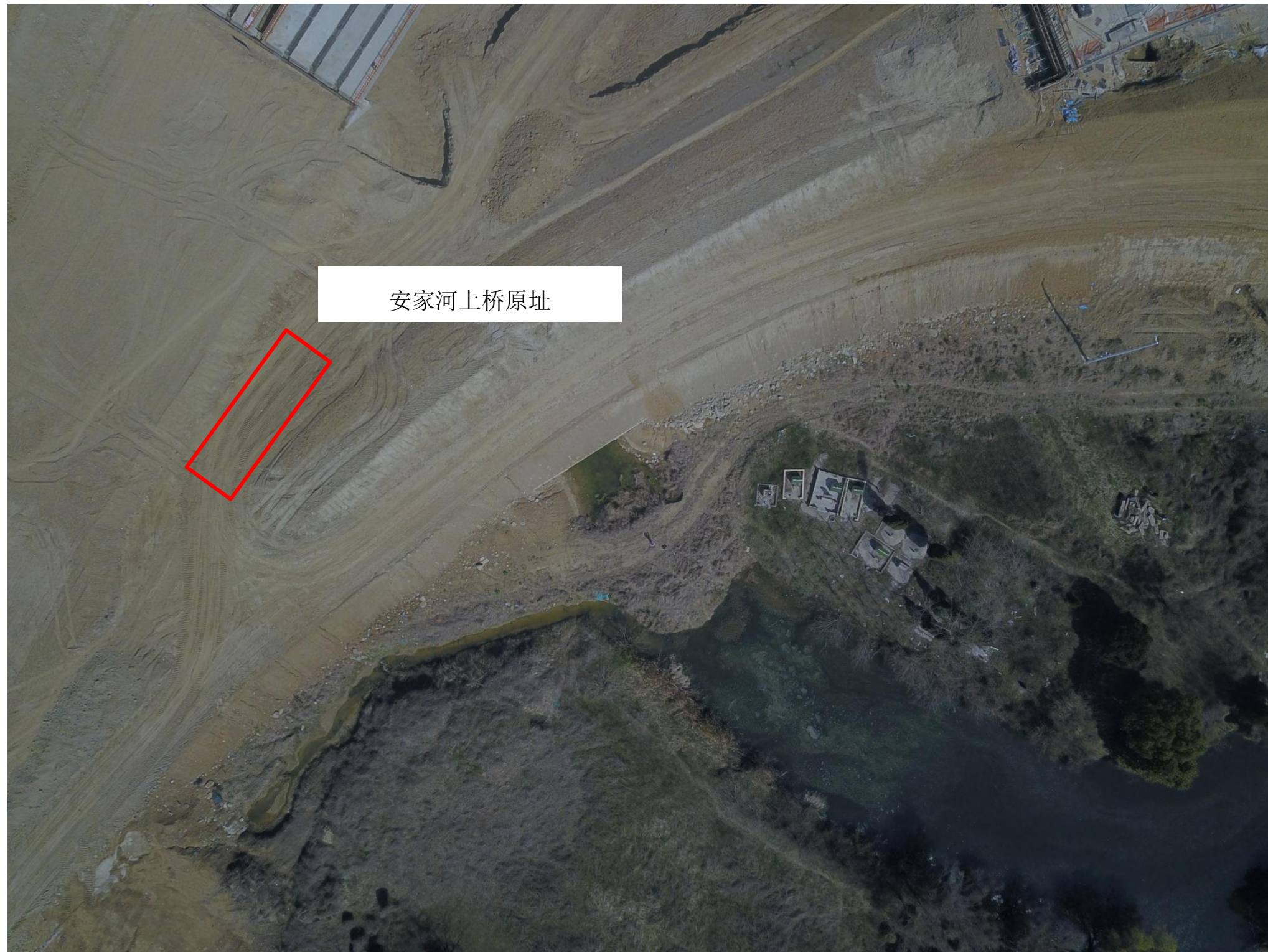
安家河上桥现状航拍
