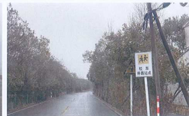
注意交叉口标志老化
