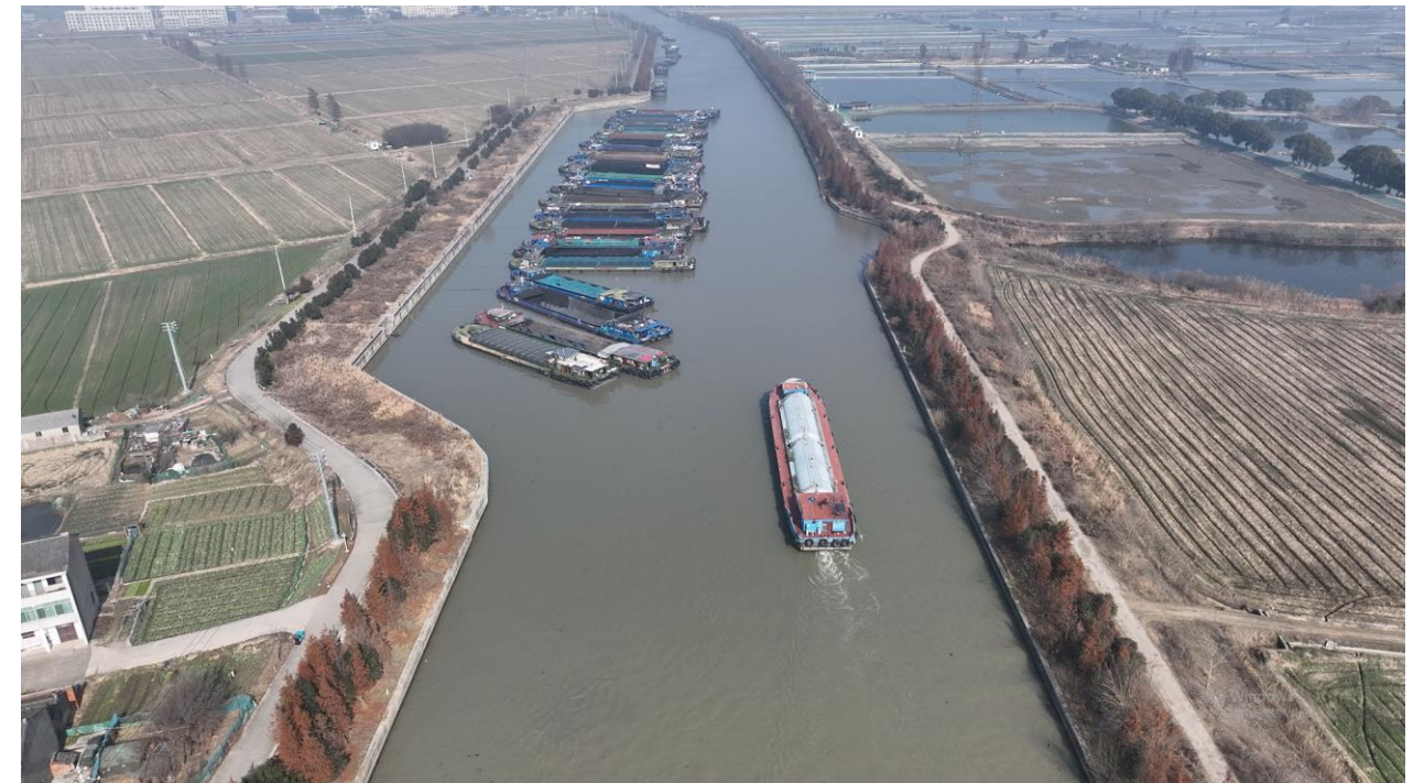
图 1-2 丹金溧漕河别桥锚地现状照片
