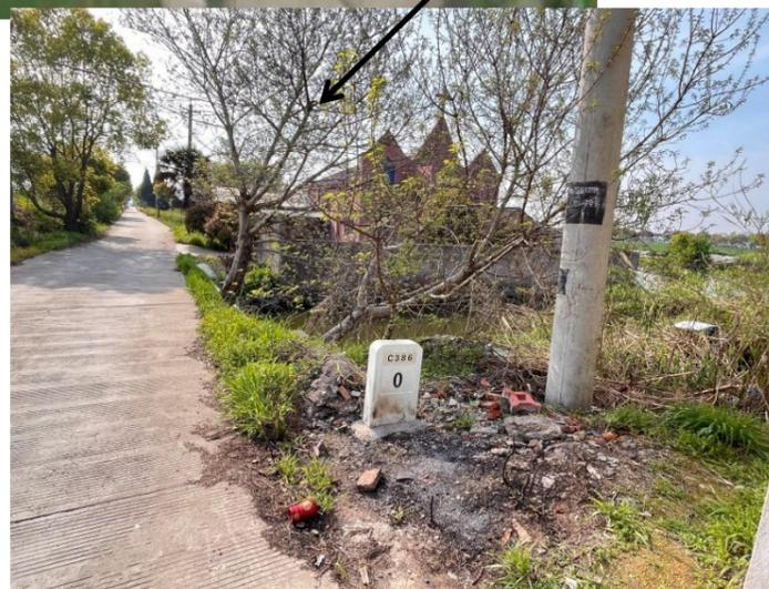
3、道路有很长一段在北侧有河塘，南侧有农田，路面高差大，车辆行驶存在安全隐患，需安装安全防护栏杆和警示桩，长度各约120米；
