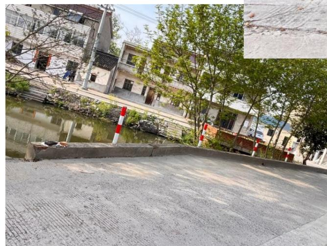
5、道路路面有裂缝，路面不平整，需修复，面积约20平方米；
