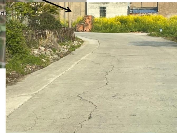
1、道路路面有多处出现裂缝，导致路面不平整，需重做，面积约720平方米。
