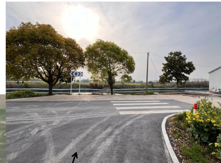
13、丁字路况无防护，标识牌为非反光膜材质，存在安全隐患，需加装反光膜材质警示牌，并安装警示桩，长度约30米；
