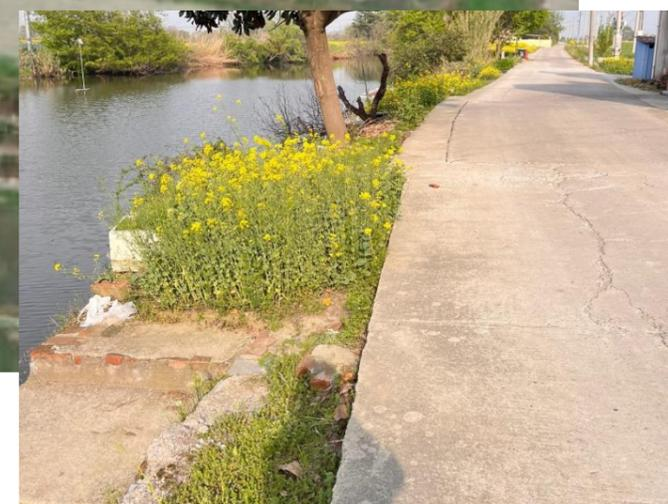
9、路面多处破碎板、裂缝，需重做，面积约120平方米；
