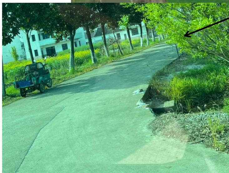
3、路口的转角处，道路两边有沟渠，路面行驶存在安全隐患，需安装安全防护栏杆，长度约35米；
