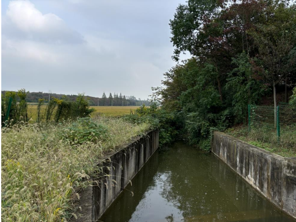
图 3-5 溢洪道下游照片
